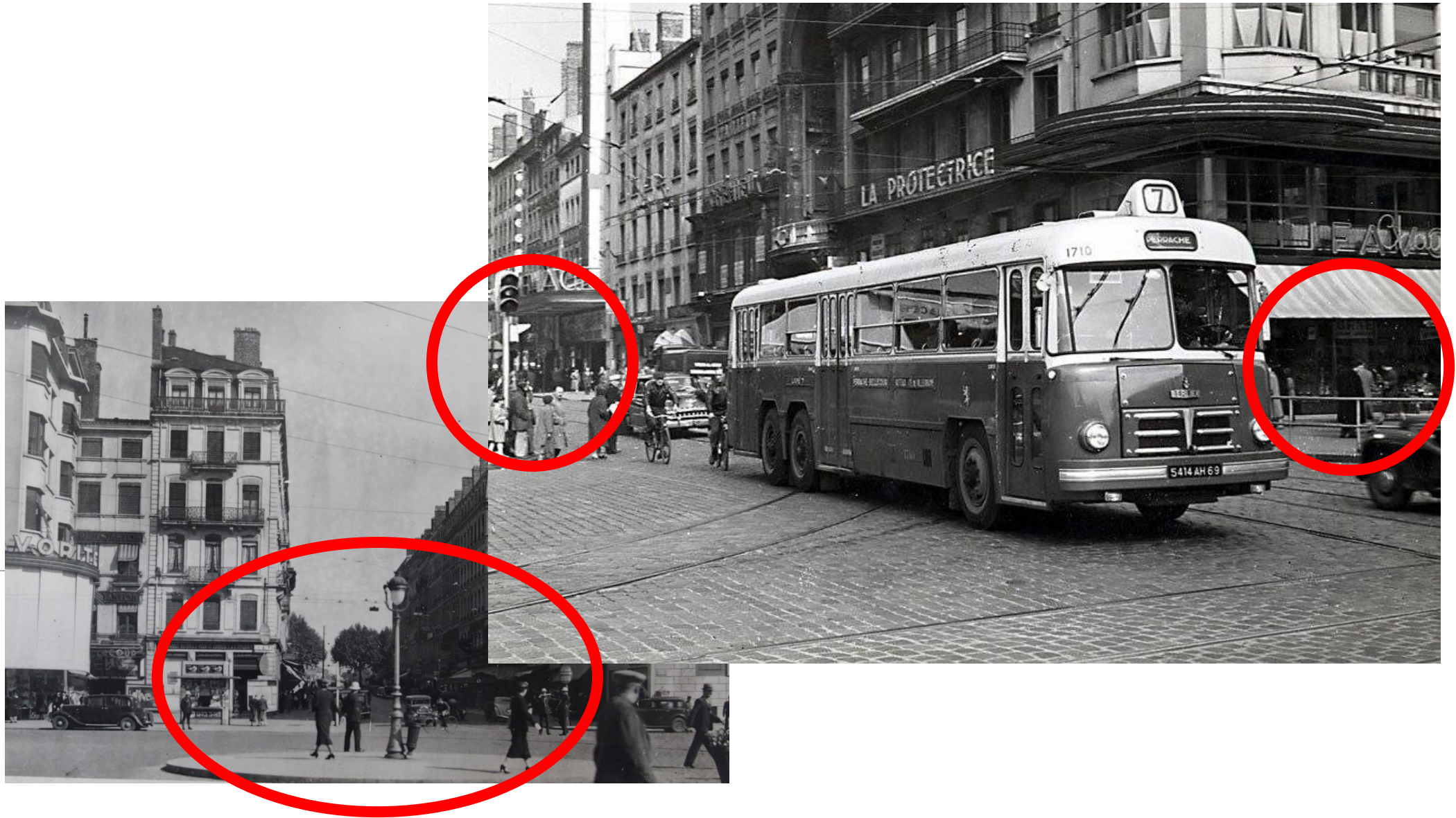
Refuge pour piétons et barrières, place Bellecour/Le Viste, cartes postales, ADR 2257W34 (1930's) AML 38PH191 (1950's).
